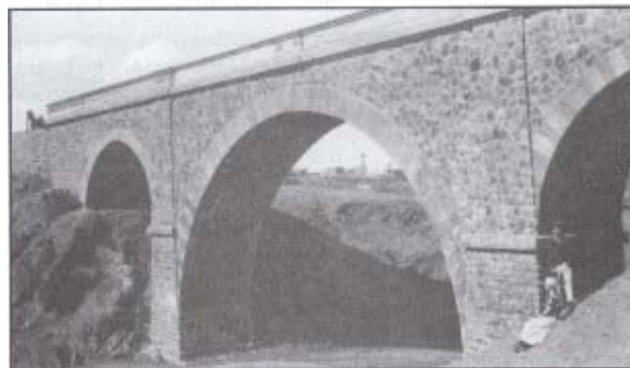
Puente internacional (Villazón - La Quiaca)
