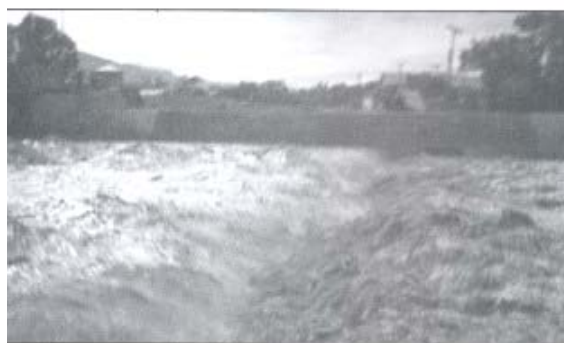
Dique soportando una crecida
