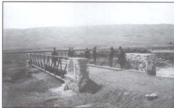
Puente construido en seco para posterior desvío del río
