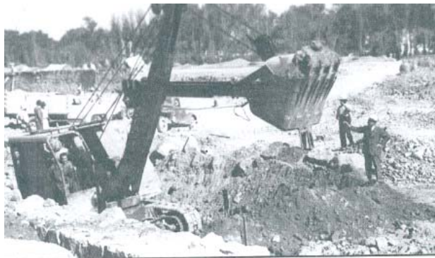
Pala mecánica en trabajo
