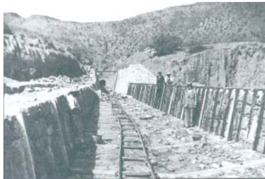
Canal de aducción en construcción
