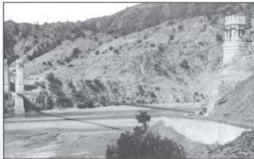
Vista del Puente
