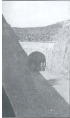
Túnel de desagüe San Miguel
