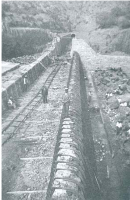
Presas derivadota de ingreso al túnel de San Pedro, en construcción
