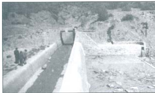
Canal de aducción hacia el túnel de San Pedro
