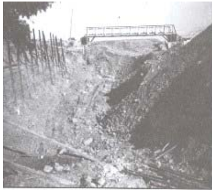
Excavación para cimiento de los diques
