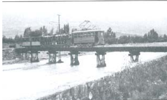
Antiguo puente del tranvía a Cala-Cala
