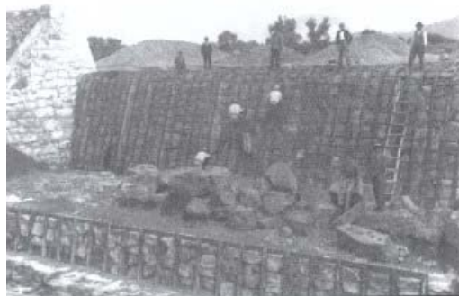
Otra vista de la presa derivadora en construcción
